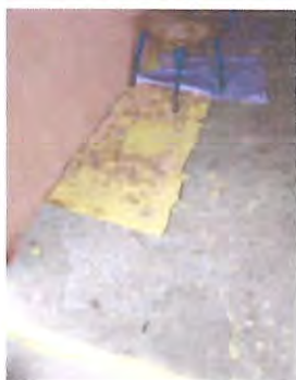
PISO, SUSTITUCION DE PISO DE CONCRETO EN MAL ESTADO POR PISO CERAMICO
