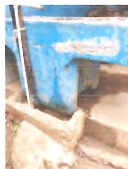
SUSTITUCION DE PILA, EN AREA DE COCINA
