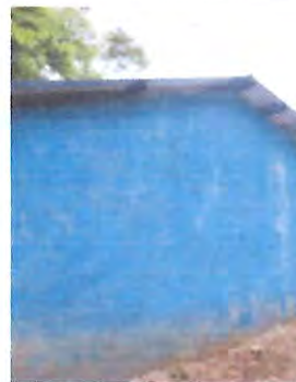
PINTURA EN PAREDES EXTERIORES DEL ESTABLECIMIENTO
