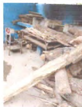
REPARACION DE ESTUFA RURAL, EN MAL ESTADO
