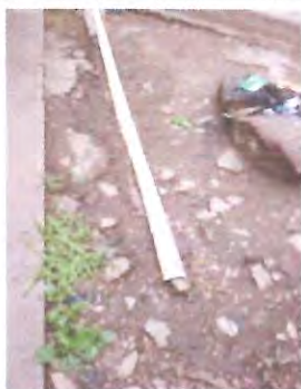
SUSTITUCION DE RED DE DRENAJE
